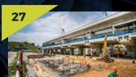
22 Pandangan udara kerja-kerja sedang dijalankan bagi aras ruang legar stesen dan pelancaran galang kekotak berseghmen di tapak Stesen MRT Taman Naga Emas.
