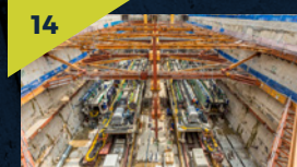
13 Pandangan pelancaran mesin pengorek terowong di tapak Stesen MRT Titiwangsa.
