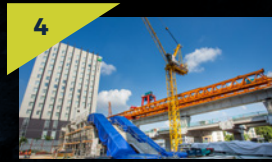
3 Pandangan udara kerja-kerja landasan sedang dijalankan di tapak Stesen MRT Damansara Damai.
