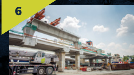
1 Penyiapan pembinaan galang kekotak berseghmen menggunakan kaedah tresel di jajaran MRT Lluhan Sungai Buloh-Serdang-Putrajaya (SSP) berhampiran dengan Sekolah Antarabangsa IGB.
