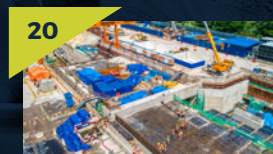
19 Pandangan kerja-kerja penggalian sedang berlangsung di tapak Stesen MRT Chan Sow Lin.
