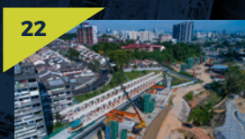
21 Pandangan udara pemasangan gantri dan kerja-kerja pelancaran rasuk berbentuk T di tapak Stesen MRT Kuchai Lama.
