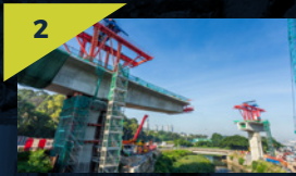
1 Penyiapan pembinaan galang kekotak berseghmen menggunakan kaedah tresel di jajaran MRT Lluhan Sungai Buloh-Serdang-Putrajaya (SSP) berhampiran dengan Sekolah Antarabangsa IGB.
