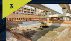
3 Kerja persediaan platform untuk pembinaan bangunan utiliti stesen di tapak Stesen MRT Damansara Damai.
