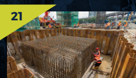
21 Kerja-kerja pembinaan tukup cerucuk di tapak Stesen MRT Kuchai Lama.
