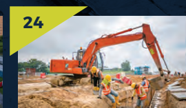
24 Pembinaan sub-balast di tapak Depoh Serdang.
