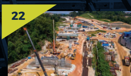
22 Pandangan dari udara kerja-kerja pembinaan rasuk portal di tapak Stesen MRT Taman Naga Emas.
