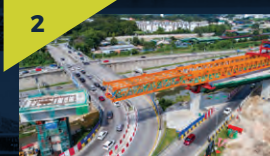
2 Pandangan dari udara kerja-kerja gantri pelancar berdekatan susur masuk ke Tol Sungai Buloh.
