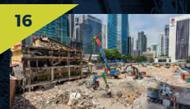
16 Kerja-kerja perobohan bekas Pusat Membeli-Belah Ampang Park sedang dijalankan bersebelahan dengan tapak Stesen MRT Ampang Park.
