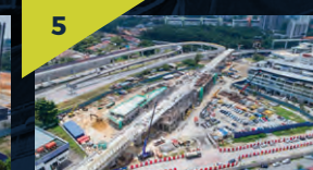
5 Pandangan dari udara kerja-kerja stesen dan pemasangan tiang penghadang bunyi jejambat di tapak Stesen Damansara Timur.
