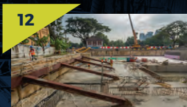
12 Kerja-kerja pembinaan papak bumbung Pintu Masuk B untuk Stesen MRT Sentul Barat.
