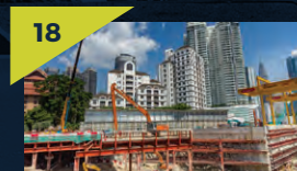
18 Kerja-kerja mengorek tanah di tapak Stesen MRT Conlay.
