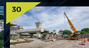
30 Pelancaran rasuk T di tapak Stesen MRT Putrajaya Sentral.
