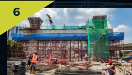
6 Pemasangan acuan untuk kerja-kerja konkrit sedang dijalankan di tapak Stesen MRT Kepong Sentral.
