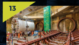
13 Persediaan fasiliti untuk pelancaran mesin pengorek terowong di tapak Stesen MRT Titiwangsa.
