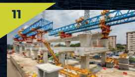
11 Kerja melancar galang kekotak bersegi menggunakan kaedah gantri pelancar di tapak Stesen MRT Kampung Batu.
