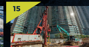
15 Kerja-kerja pembinaan blok intervensi sedang dijalankan di tapak Stesen MRT Kampung Baru Utara.
