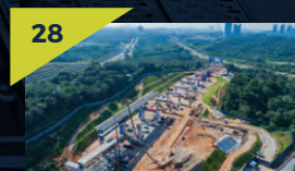
28 Pandangan dari udara kerja pelancaran galang kekotak bersegi di tapak Stesen MRT Cyberjaya Utara.
