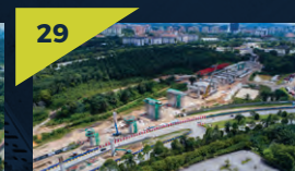
29 Pandangan dari udara kerja pelancaran galang kekotak bersegi di tapak Stesen MRT Pusat Bandar Cyberjaya.
