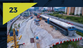
23 Kerja persediaan dataran tapak dan akses untuk kerja pelancaran di tapak Stesen MRT Serdang Raya Utara.
