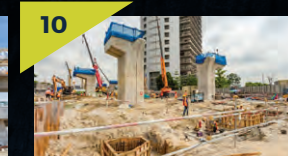
10 Pembinaan tukup cerucuk di tapak Stesen MRT Sri Delima.
