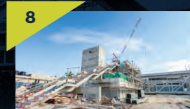
8 Pembinaan Pintu Masuk 2 di Stesen MRT Kepong Baru.
