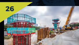
26 Pembinaan tiang di tapak Stesen MRT Taman Putra Permai.
