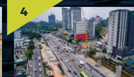
4 Pembinaan segmen pra-pasang berbentuk T di tapak Stesen MRT Damansara Barat.
