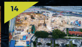
14 Pandangan dari udara tapak Stesen MRT Hospital Kuala Lumpur dan kerja-kerja pembinaan tembok diafragma dan aktiviti-aktiviti mencampur simen.
