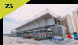
Galang kekotak bersegi sedang dipasang menggunakan kaedah rerangka di tapak Stesen Seri Kembangan.
