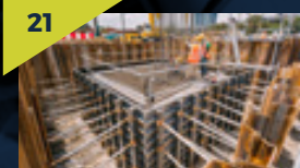
Pembinaan tukup cerucuk di tapak Stesen Kuchai Lama.
