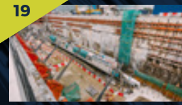
Jangkar tanah dan kerja pengukuhan batu di tapak Stesen MRT Chan Sow Lin.
