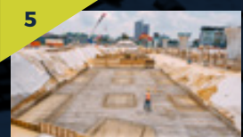
Persediaan pembinaan papak lantai di tapak Stesen MRT Sri Damansara Timur di Bandar Sri Damansara.
