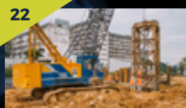
Ujian cerucuk gerak sedang dijalankan di tapak Stesen Taman Naga Emas.
