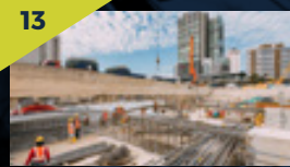
Kerja tetulang keluli di tapak Stesen MRT Titiwangsa.
