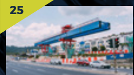
Gantri pelancar didirikan untuk pelancaran galang kekotak bersegi di tapak Stesen Equine Park di Seri Kembangan.
