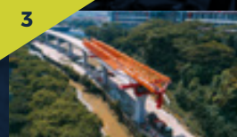
Gantri pelancar untuk pelancaran galang kekotak bersegi yang dilancarkan di Bangunan Pameran Muhibbah di Prima Damansara.
