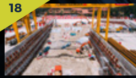
Kren gantri di atas kekotak Stesen Conlay.
