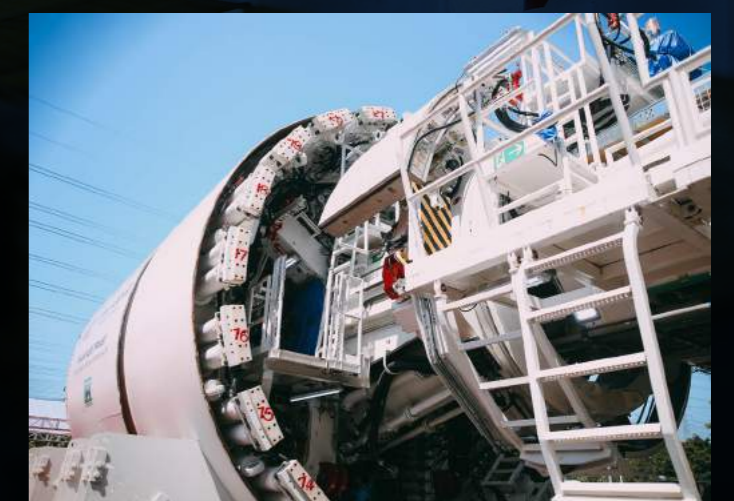
PENGGALIAN TEROWONG: Kebuk penggalian bertekanan bagi Mesin Pengorek Terowong Pembolehubah Ketumpatan yang membuang bahan-bahan yang telah digali.
