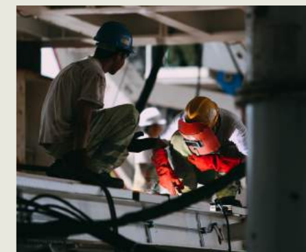
DI KILANG: Para pekerja di Herrenknecht Tunnelling Machinery Co. Ltd. di Guangzhou, China sedang bertungkus lumus menyiapkan TBM.
