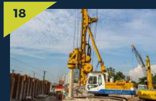
Kerja-kerja cerucuk gerak yang sedang dijalankan berdekatan dengan Selangor Turf Club.
