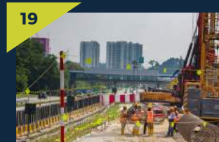
Kerja-kerja cerucuk gerak sedang dijalankan di tapak Stesen MRT Equine Park.
