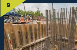
Kerja-kerja tukup cerucuk sedang dijalankan di tapak Stesen MRT Seri Delima.
