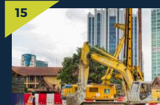
Kerja-kerja cerucuk gerak sekan di tapak Stesen MRT Conlay.
