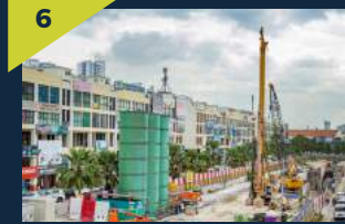
Kerja-kerja cerucuk gerak di tapak Stesen MRT Metro Prima.
