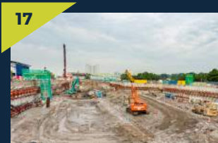
Kerja-kerja ekskavasi kotak stesen di tapak Stesen MRT Bandar Malaysia North.
