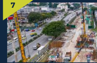
Kerja-kerja cerucuk gerak dan pembinaan tukup cerucuk di tapak Stesen MRT Kepong Sentral.
