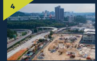
Pembinaan tiang sedang dijalankan di tapak Stesen MRT Sri Damansara East.
