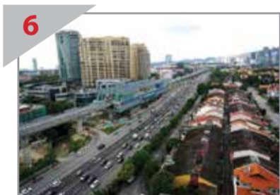
6 继续迈进 万达镇捷运站的建筑工程正在进行中。
