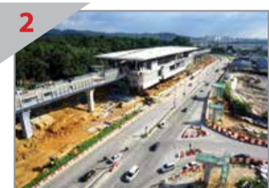
2 工程正在进行中 靠近梳邦路（Jalan Subang）交界处、双溪毛糯新村附近的甘榜士拉马（Kampung Selamat）捷运站。
