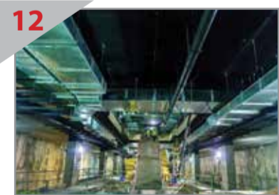
12 设备就位 在国家博物馆捷运站月台安装服务设备，例如月台层的空调通风口。
