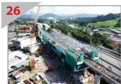
26 建筑结构 蕉赖十一哩捷运站的站顶架已准备安装站顶。
