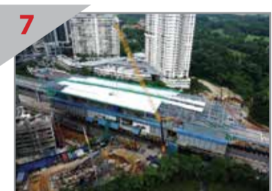
7 工作良好 敦依斯迈花园捷运站正在安装站顶。
