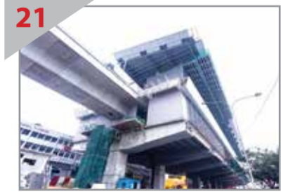
21 几近完工 第一花园捷运站的建筑工程。
