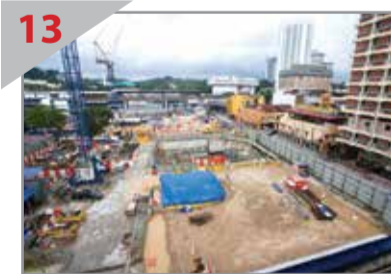
13 回填 中央艺术坊捷运站的站顶上正在进行填平工程。
