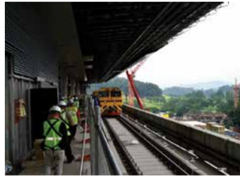
■ 工作中： 工程列车在媒体进行访问时经过捷运站。
