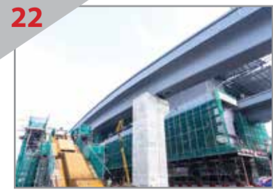
22 出入口 珍珠花园捷运站其中一个出入口正在进行建设。
