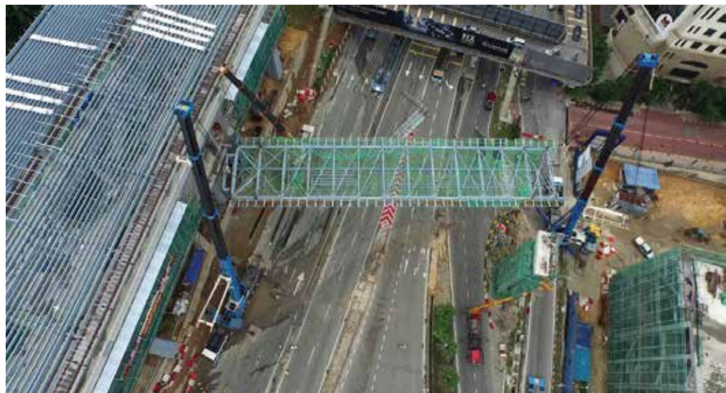
■ 壮观：鸟瞰图显示吊升连接桥梁时的情况。
