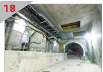
18 准备就绪 葛京捷运站月台层的设备已准备进行安装。
