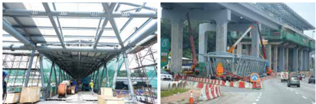
■ 覆盖：连接桥梁的桥顶和其它工作正在进行中。
