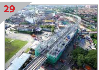
29 良好地点 加影体育场捷运站正在施工，地点就在加影市中心旁边。
