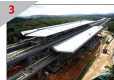
3 几近完工 白沙罗捷运站的建筑工程已进入后期阶段。
