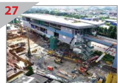
27 工程良好 图示武吉杜贵捷运站以及隔壁正在施工的停车换乘设施。
