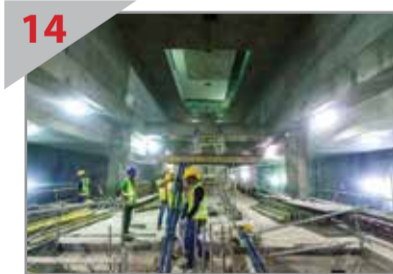
14 捷运站内部 默迪卡捷运站的月台层。
