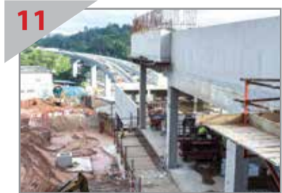
11 进入地下 高架轨道进入瑟曼丹出入口的建筑，此处也是捷运地下路线的开端。
