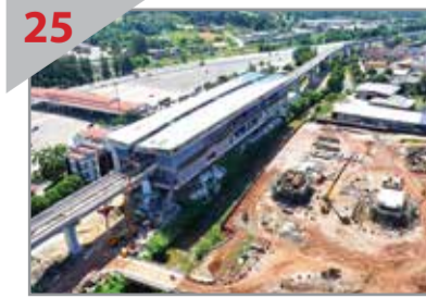
25 方便 敦胡先翁镇捷运站的右侧正在兴建着停车换乘设施。
