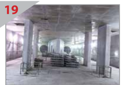
19 庞大站箱 图示马鲁里站箱的横渡线 (Crossover) 区正在准备铺轨工作。
