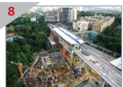
8 最后部分 Phileo Damansara捷运站的站顶已接近完工。
