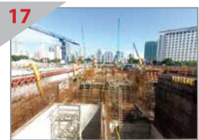
17 庞大工地 敦拉萨交易中心 (TRX) 捷运站站箱北端的部分顶板 (白板) 已完成。
