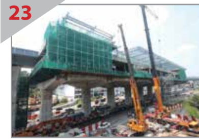
23 如火如荼 康乐花园捷运站的建设正在进行中。
