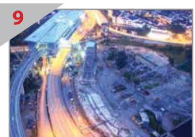
9 出入口建竣 白沙罗市中心捷运站的其中一个出入口就建在右方。
