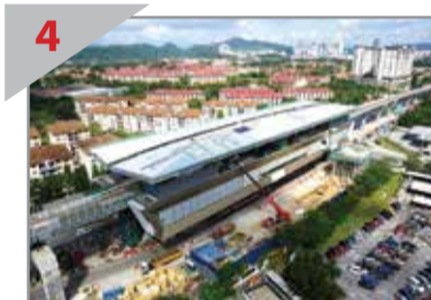
4 逐渐成形 哥打白沙罗捷运站的建筑工程取得良好进展。
