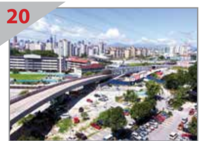
20 升上地面 马鲁里出入口就是捷运双溪毛糯—加影线从地底上升至地面的地点。
