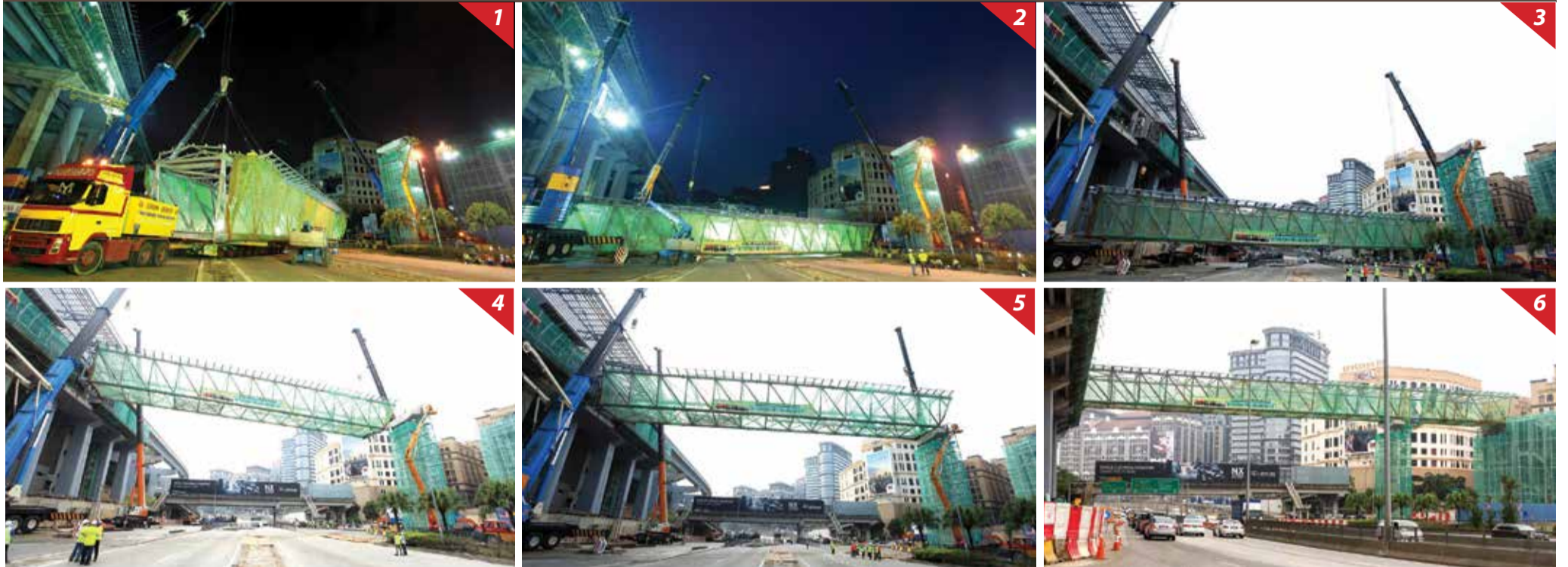
Operasi untuk membina jejantas pejalan kaki di Stesen Phileo Damansara bermula pada petang 5 September 2015 di mana rangka keluli dianjak ke posisi (Gambar 1) bagi membolehkan proses mengangkat dijalankan (Gambar 2-4). Struktur jejantas telah dipasang di posisi di antara stesen dan tiang pada lewat pagi 6 September 2015 (Gambar 5). Pada 23 September 2015, seksyen kedua pula dipasang antara tiang dan bangunan pintu masuk (Gambar 6), justeru menyelesaikan struktur jambatan.
