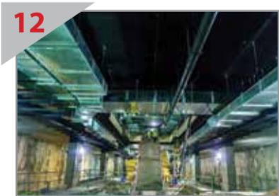
KELENGKAPAN DIPASANG Kelengkapan perkhidmatan bangunan seperti lohong penyium udara dipasang di aras platform Stesen Muzium Negara.
