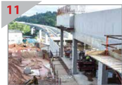
KE BAWAH TANAH Pandangan landasan bertingkat MRT memasuki Portal Bangunan Semantan yang merupakan permulaan jajaran bawah tanah.
