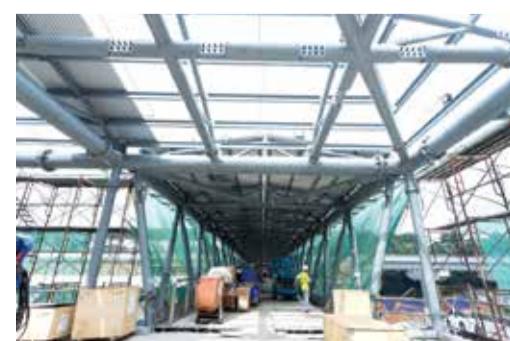
PENUTUP: Kerja pemasangan bumbung dan lain-lain kerja sedang dijalankan di jejantas.
