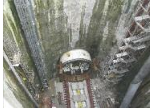
RUANG KERJA SEMPIT • Bahagian depan mesin pengorek terowong sedang dimasukkan ke dalam galeri Syaf Inai Bahagian Atas.
