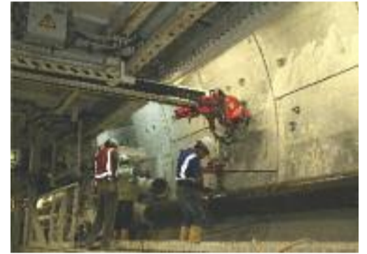
BEKERJA KUAT • Pekerja-pekerja menyambung saluran cecair dan lumpur bagi mesin pengorek terowong di dalam terowong.
