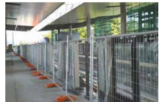
■ PENCAPAIAN BAIK: Pandangan pintu skrin platform di belakang pagar keselamatan di aras platform stesen.
