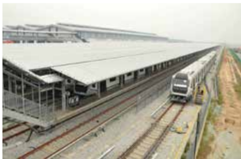
■ PERCUBAAN: Tren MRT di atas trek percubaan Depoh Sungai Buloh.
