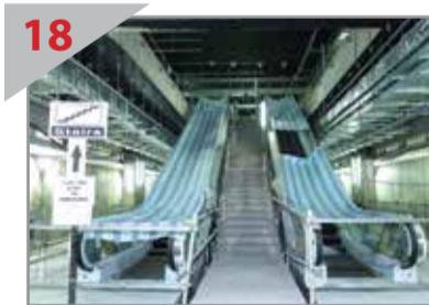
SIAP DIPASANG: Eskalator dipasang di dalam Stesen Cochrane.
