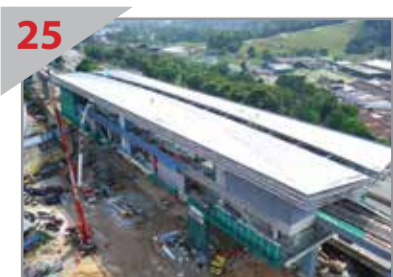
25 LANDASAN YANG BETUL: Pembinaan di Stesen Batu Sebelas Cheras sedang dijalankan.
