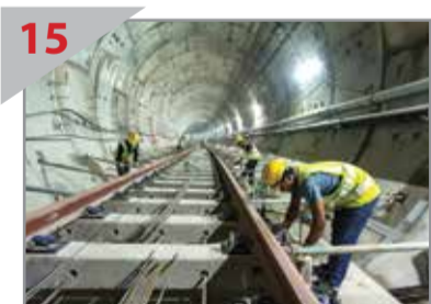
15 KERJA SEDANG BERJALAN: Kerja-kerja pemasangan landasan sedang dijalankan di dalam terowong berdekatan Syaf Pudu.
