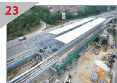
23 PEMASANGAN BUMBUNG: Pandangan Stesen Taman Suntext dengan bumbungnya yang sedang dipasang.
