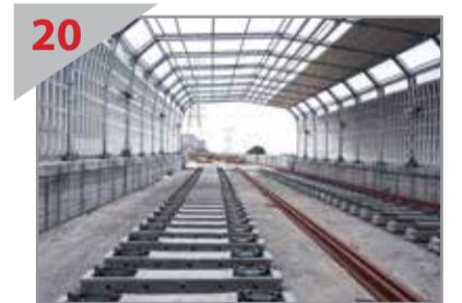
PENGHUJUNG TEROWONG: Kerja-kerja pemasangan landasan sedang dijalankan di atas tapak landasan yang dikelilingi dengan penghadang bunyi di Portal Maluri.
