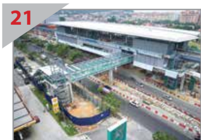
21 JEJANTAS STESEN: Pandangan Stesen Taman Midah dengan jejantas pejalan kaki yang melintasi Jalan Cheras sedang dibina.
