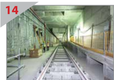
14 TREK DIPASANG: Pekerja-pekerja memasang braket kabel sementara menunggu landasan dikonkrit di kawasan platform Stesen Merdeka.
