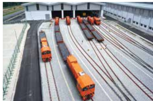
■ MESIN KERJA: Tren-tren kerja di hadapan Bangunan Bengkel Infrastruktur di Depoh Sungai Buloh yang digunakan untuk pembaikan dan penyelenggaraan infrastruktur pada masa akan datang.
