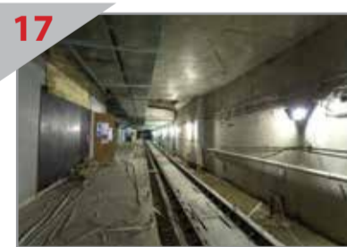
MULAI TERBENTUK: Kerja mengkonkrit landasan selesai di kawasan platform Stesen Tun Razak Exchange.
