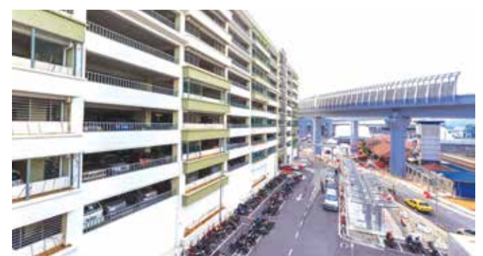
■ MUDAH: Bangunan Letak Kereta Bertingkat Sungai Buloh yang akan digunakan oleh penumpang MRT dan KTM Komuter.
