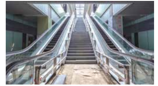
■ AWASI LANGKAH ANDA: Eskalator dari aras ruang legar ke aras platform yang siap dipasang di Stesen Phileo Damansara.
