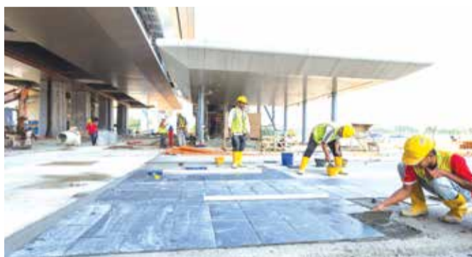
■ PEMBINAAN RANCAK BERJALAN: Kerja-kerja pemasangan jubin lantai di salah sebuah pintu masuk di Stesen Kwasa Sentral.
