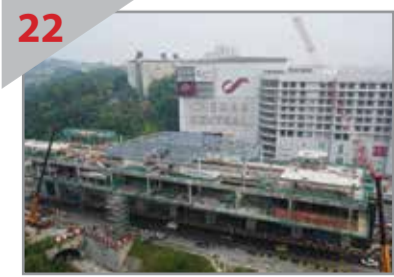
22 RANCAK Pembinaan Stesen Taman Suntext sedang rancang dijalankan.
