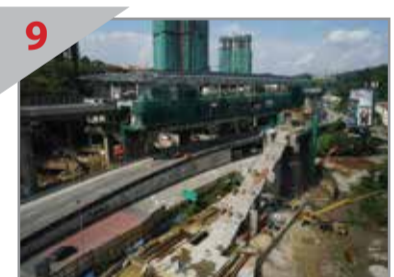
9 LALUAN MASUK Tangga, eskalator dan lif di salah satu pintu masuk ke Stesen Pusat Bandar Damansara sedang dibina.
