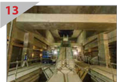
13 STRUKTUR SIAP Pandangan tangga yang menghubungkan aras platform ke aras ruang legar di Stesen MRT Pasar Seni. Ruang di sisi kiri dan kanan tangga adalah untuk eskalator.
