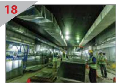
18 PEMASANGAN SEDANG BERJALAN Pandangan aras platform di Stesen Cochrane di mana alat kelengkapan perkhidmatan bangunan seperti saluran penghawa dingin sedang dipasang.
