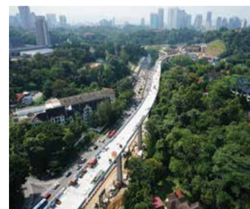
■ SELESAI: Pembinaan jajaran di sepanjang Jalan Sultan Abdul Hamid (Jalan Duta) pada bulan Jun (kiri) dan pada bulan Ogos (kanan).
