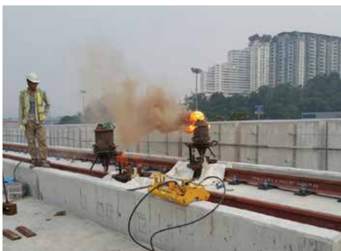
■ DRAMATIK: Proses kimpalan rel sedang dijalankan.
