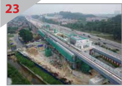
23 PLATFORM TENGAH Pandangan pembinaan Stesen Bandar Tun Hussein Onn mempunyai platform antara dua trek.
