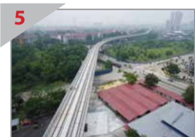
5 SELESAI Pandangan dari udara jejambat MRT menghala ke Persiaran Surian yang telah siap dibina dan dipasang dengan trek.
