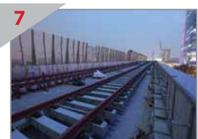
7 DALAM PEMBINAAN Kerja-kerja pemasangan trek di atas jejambat berdekatan Stesen Mutiara Damansara.
