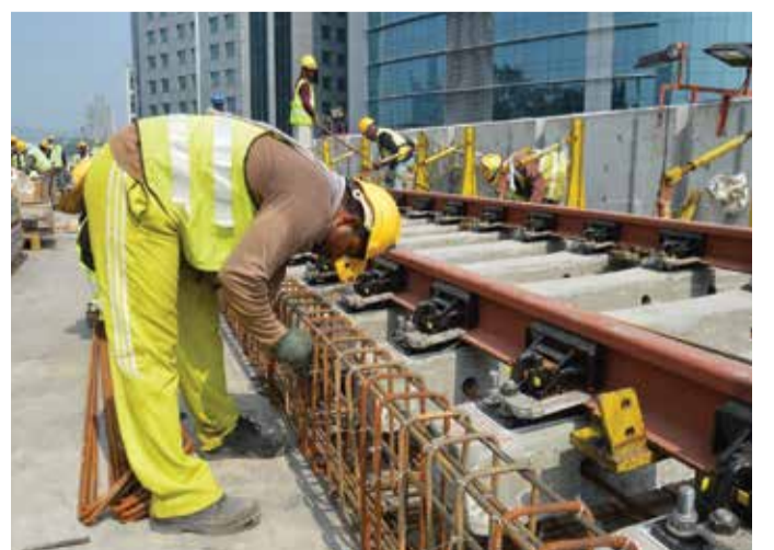
■ DALAM PEMASANGAN: Pekerja sedang memasang tetulang keluli bagi kerja konkrit.
