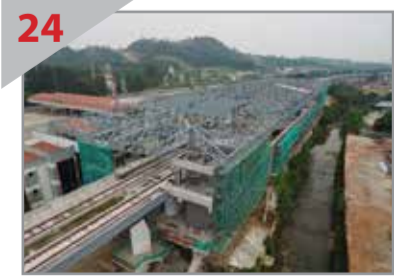
24 KERJA TERUS DIJALANKAN Stesen Bandar Tun Hussein Onn dalam pembinaan.
