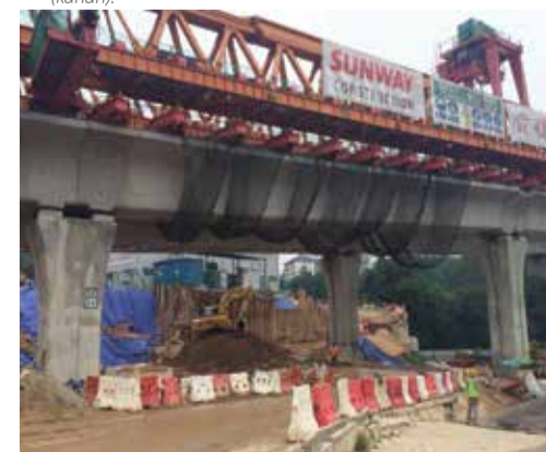
■ BAHAGIAN TERAKHIR: Rentang jajaran terakhir didirikan untuk jajaran bertingkat MRT Laluan Sungai Buloh-Kajang.
