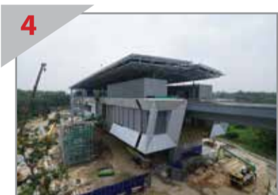
4 MENARIK Kerja-kerja seni bina di Stesen Kwasa Sentral sedang dijalankan.
