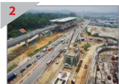
2 KEMAJUAN TERBAIK Bumbung Stesen Kampung Selamat sudah siap dipasang.
