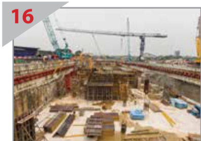
16 PENGHABISAN Pandangan acuan untuk pembinaan papak bumbung Stesen Tun Razak Exchange yang sedang berjalan di aras ruang legar atas.
