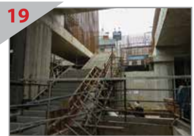
19 MULAI TERBENTUK Pembinaan tangga daripada aras platform ke aras ruang legar di Stesen Maluri sedang dijalankan.
