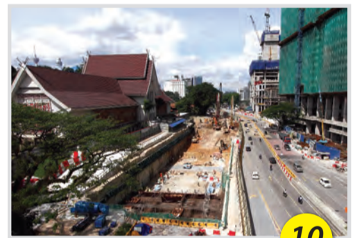
GIAT DIJALANKAN Pandangan Stesen MRT KL Sentral menunjukkan pembinaan siling yang sedang dijalankan.
