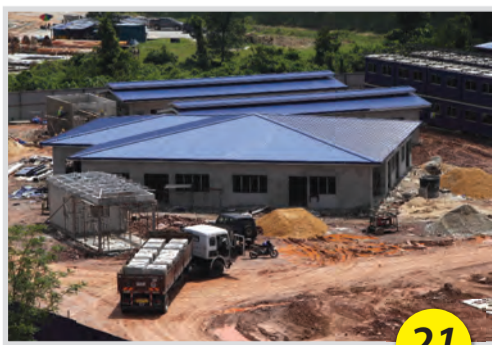
TEMPAT TINGGAL Kerja-kerja pembinaan Kwarters Pekerja (CLO) Kajang semakin jelas.
