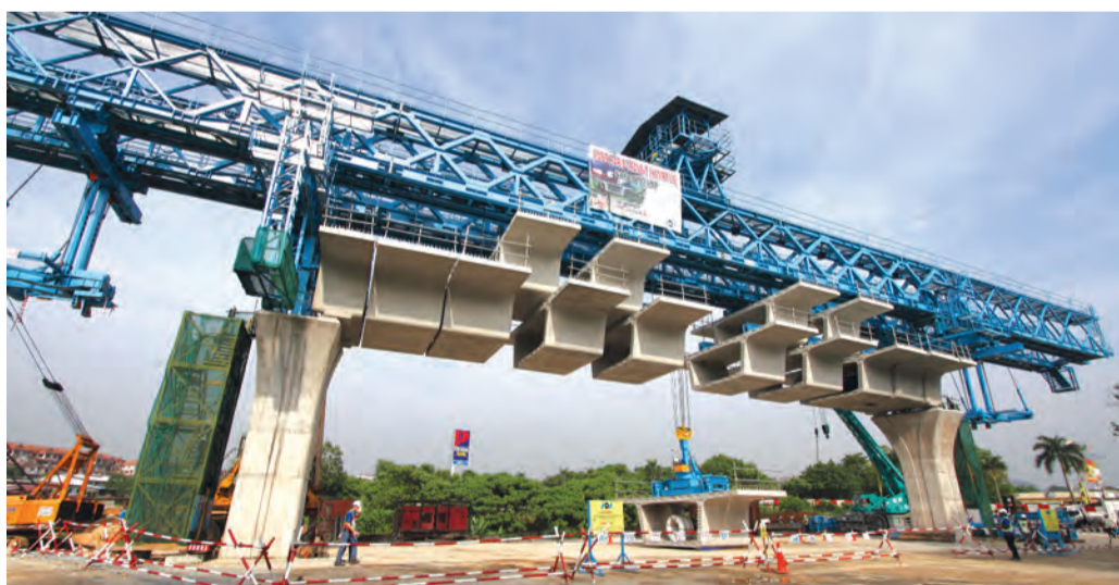
KERJA BERAT • Gantri pelancaran mengangkat SBG ke posisi yang sesuai.
