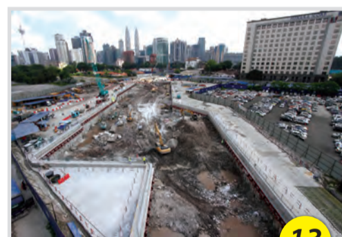
PENGKALIAN DALAM Kerja-kerja pengkalian di petak Stesen Pasar Rakyat.
