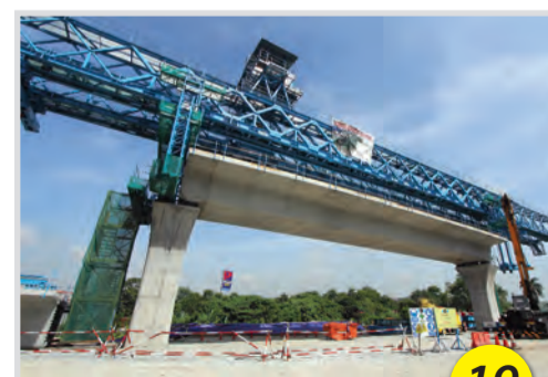
SIAP Jejambatan pertama siap dipasang di Bandar Tun Hussein Onn. Ia dibina dengan mencantumkan satu persatu galang kekotak bersegmen (SBG) menggunakan sebuah gantri pelancaran (struktur keluli biru).
