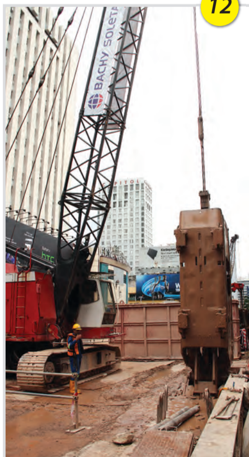
JENTERA BESAR Sebuah jentera "clamshell grab" digunakan untuk menggali parit bagi pembinaan dinding diafragma di Stesen MRT Bukit Bintang.
