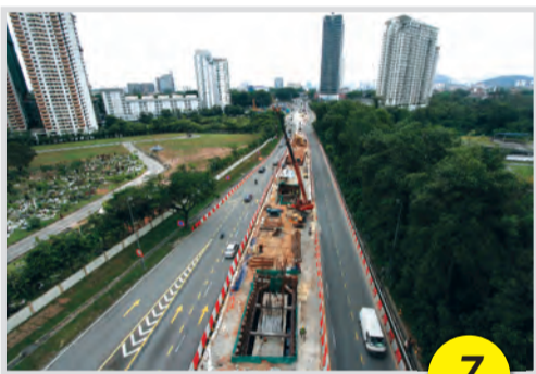
GIGIH BEKERJA Jentera membina cerucuk di sepanjang median Jalan Damansara berdekatan dengan Tanah Perkuburan Islam Bukit Kiara.
