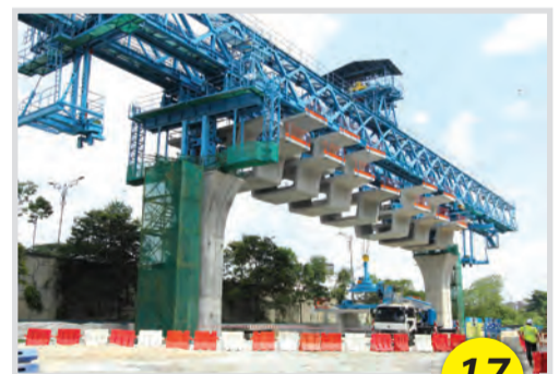
DIPASANG Ujian muatan sedang dijalankan bagi gantri pelancaran galang kekotak bersegmen (SBG) yang pertama untuk Pakej Kerja V5 berhampiran Flat Sri Sabah di Cheras.
