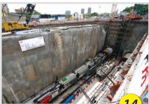
TERKINI Mesin pengorek terowong Variable Density yang pertama telah memulakan kerja-kerja penggalian terowong. Mesin yang kedua, separa tersembunyi di sebelah kanan, juga telah memulakan kerja penggalian terowong.
