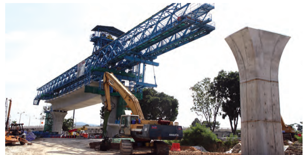
SIAP • Setelah bidang jejambat pertama antara Tiang 132 dan 133 siap, gantri pelancaran akan bergerak ke hadapan bagi membina bidang jejambat yang seterusnya antara Tiang 133 dan 134.
