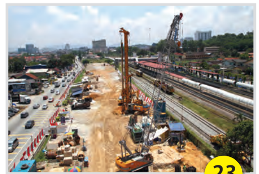
STESEN BAHARU Kerja-kerja memantapkan cerucuk di sepanjang Jalan Reko berdekatan Stesen KTM Kajang.
