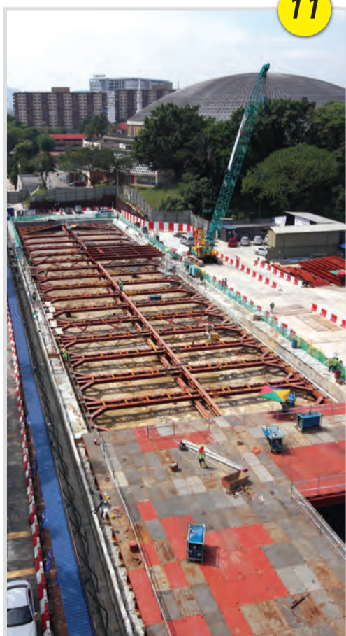
KAWASAN BERSEJARAH Pandangan Stesen Merdeka dari udara, berdekatan Stadium Merdeka, menunjukkan tupang (struts) peringkat pertama yang telah dipasang.
