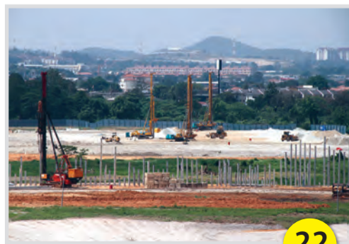
LUAS Kerja-kerja memantapkan cerucuk bagi bangunan pentadbiran Depoh Kajang sedang dijalankan.
