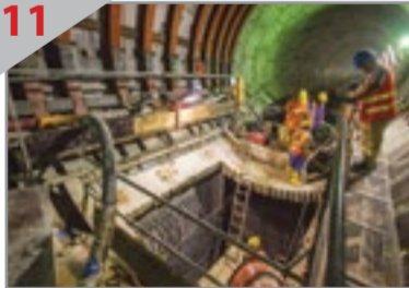
11 SISTEM SALIRAN AIR Pembinaan tempat takungan air bagi sistem saliran air di terowong bawah tanah antara Portal Semantan dan Stesen MRT Muzium Negara.
