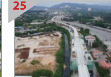
25 DALAM PEMBINAAN Pandangan udara Stesen MRT Bandar Tun Hussein Onn.
