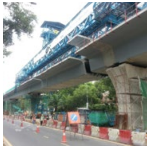
■ HAMPIR LENGKAP • Gantri pelancar sedang mengangkat galang kekotak bersegmen untuk melengkapkan jambatan bertingkat MRT.
