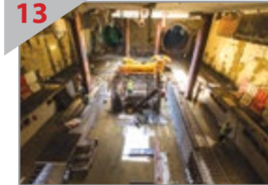
13 KAWASAN PLATFORM Pandangan bukaan dua terowong bawah tanah di Stesen MRT Pasar Seni semantara proses pembinaan platform sedang dijalankan.
