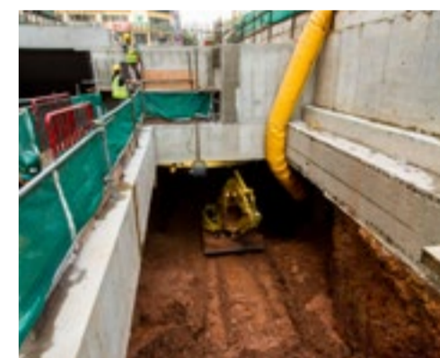
■ ATAS KE BAWAH • Melalui kaedah atas ke bawah, penggalian bagi kekotak stesen dilakukan setelah papak bumbung dibina.
