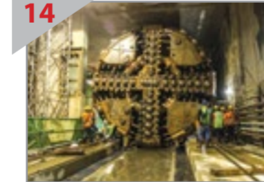
14 BERJAYA Pandangan Mesin Pengorek Terowong Pudu 1 di Stesen Merdeka selepas ia berjaya menembusi dinding diafragma stesen tersebut pada 4 Januari 2015.
