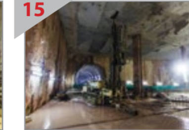
15 RUANGAN YANG LUAS Pandangan Atas Platform Atas Stesen MRT Bukit Bintang serta bukaan terowong bagi tren yang menghala ke arah Kajang.
