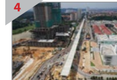
4 JEJAMBAT DIDIRIKAN Pandangan salah satu seksyen jambatan yang telah siap dan pembinaan Stesen Surian sedang dijalankan.
