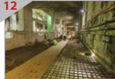
12 PERSIAPAN Pemasangan tapak landasan di dalam Stesen MRT Muzium Negara.
