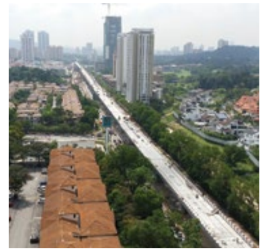
■ LALUAN BERSAMBUNG • Pandangan jambatan bertingkat MRT.
