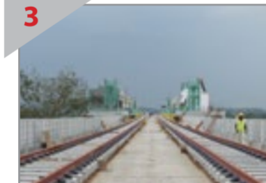
3 PEMBINAAN LANDASAN Kerja-kerja pembinaan landasan sedang dijalankan di atas jambatan MRT di kawasan bekas tapak Institut Penyelidikan Getah Malaysia.
