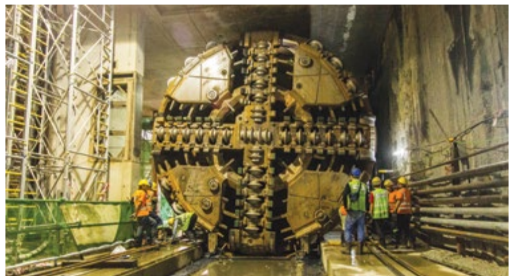
■ SEDIA MEMULAKAN TUGAS • Mesin Pengorek Terowong Pudu 1 sedang diselenggara untuk dilancarkan semula di dalam kekotak Stesen Merdeka.
