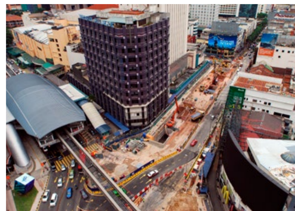
■ TAPAK KERJA YANG SEMPIT • Tapak kerja stesen dari pandangan udara.
