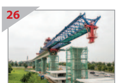
26 MESIN MENAKJUBKAN Gantri pelancar sedang membina jejubat MRT di persimpangan Sungai Balak, Lebuhraya Cheras-Kajang.
