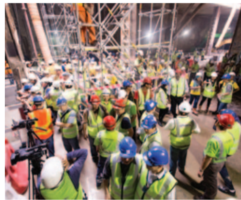
■ SABAR MENANTI • Kakitangan MRT Corp, MMC Gamuda dan subkontraktor yang lain menunggu detik penembusan TBM.
