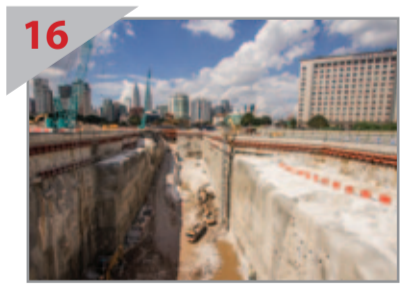
16 BATUAN KERAS Pandangan dari udara bahagian utara kekotak Stesen MRT Pasar Rakyat yang telah digali daripada batu kapur keras.
