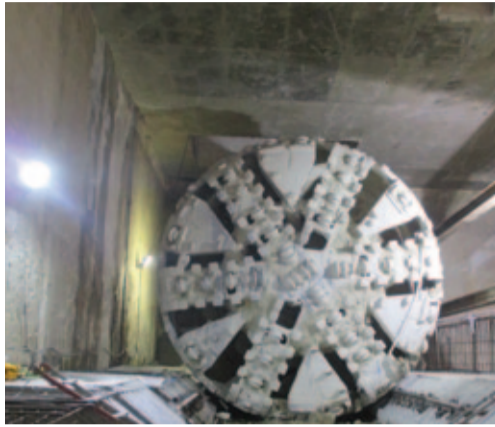
■ MENANTI KERJA SETERUSNYA • Mesin Pengorek Terowong Semantan 1 yang telah berjaya membuat penembusan di KL Sentral, menanti untuk diselenggarakan sebelum dilancarkan semula bagi menggali terowong hingga ke Stesen MRT Pasar Seni.
