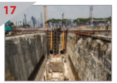
17 STESEN MULAI DIBENTUK Pandangan kekotak Stesen MRT Cochrane, yang pada mulanya digunakan sebagai syaf pelancaran bagi empat mesin pengorek terowong, di mana struktur stesen sedang dibina.
