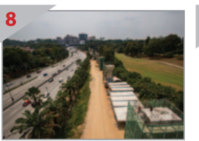
8 SEDIA UNTUK DIDIRIKAN Galang kekotak bersegmen ditempatkan di antara tiang-tiang, sedia untuk pasang bagi membina jejubat bertingkat MRT.
