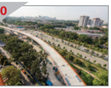
20 JEJAMBAT BERTINGKAT Salah satu jejubat MRT yang telah siap dibina dan terletak selari dengan Jalan Loke Yew di Cheras.
