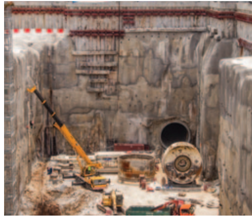
■ KERJA SELESAI • Mesin Pengorek Terowong Cochrane 2 sedang dibuka setelah menamatkan kerja penggalian terowong.
