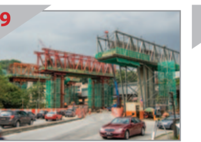
9 STRUKTUR-STRUKTUR KUKUH Kekuda besi digunakan untuk membina rasuk silang atau "cross beams" di atas Persimpangan Ma'arof bagi Stesen MRT Pusat Bandar Damansara akan datang.
