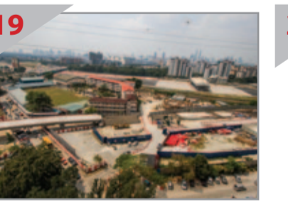
19 TITIK TRANSFORMASI Pandangan dari udara penempatan di Tapak Portal Maluri di mana trek MRT akan muncul dari bawah tanah untuk meneruskan perjalanannya di atas jejubat bertingkat (kiri).
