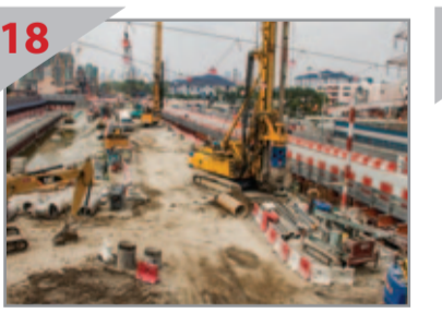
18 BEKERJA KERAS Pandangan mesin-mesin jentera di tapak Stesen MRT Maluri.
