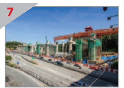
7 STESEN AKAN DATANG Pandangan kerja pembinaan sedang dijalankan di tapak Stesen MRT Seksyen 16 yang terletak berhadapan dengan Phileo Damansara.
