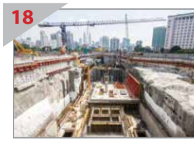
18 KERJA STRUKTUR Pandangan penghujung arah utara kekotak Stesen MRT Tun Razak Exchange, dengan sebahagian daripada papak bilik jentera aras atas (papak berwarna putih).
