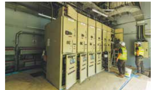
PINDAH MASUK • Kelengkapan sedang dipasang di bilik-bilik stesen.
