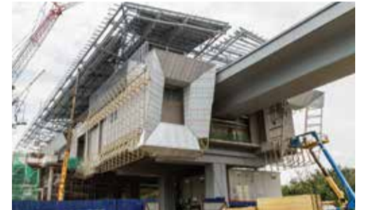
MENARIK • Lapisan aluminium sedang dipasang di Stesen Kota Damansara.
