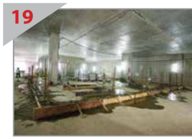
19 KEMAJUAN MENGALAKKAN Dinding dalam sedang dibina di Aras Ruang Legar Stesen MRT Cochrane.
