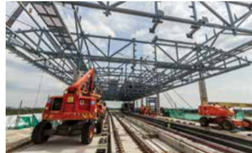
KERJA SEDANG DIJALANKAN • Bahagian kekuda bumbung dibina sebelum penutup dipasang di Stesen Kwasa Sentral.
