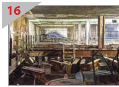
16 KERJA TANAH Penggalian sedang dijalankan di aras dasar Stesen MRT Bukit Bintang, dengan bukaan terowong arah utara turut kelihatan di bahagian belakang.
