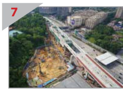
7 DALAM PEMBINAAN Pandangan udara Stesen MRT Phileo Damansara yang sedang dalam pembinaan. Turut kelihatan adalah tapak pembinaan kemudahan parkir bertingkat "Park & Ride".
