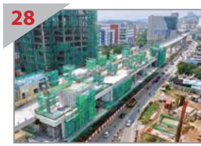
28 KERJA SEDANG DIJALANKAN Stesen MRT Sungai Kantan sedang dalam proses pembinaan.
