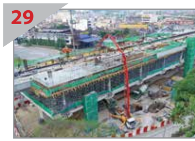
29 LOKASI STRATEGIK Pembinaan Stesen MRT Bandar Kajang bersebelahan Stadium Kajang sedang dijalankan.
