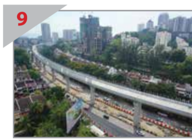
9 PENGHADANG BUNYI Peredam bunyi sedang dibina di atas jambat MRT yang telah siap di sepanjang Lebuhraya SPRINT berhampiran Medan Damansara.
