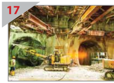
17 AKSES BERKEMBAR Kerja pengorekan sedang dilakukan untuk menghasilkan laluan dari Syaf Bersilang No.2 di Bukit Bintang ke terowong arah utara.
