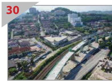
30 MERENTASI TREK Pandangan udara jambat MRT yang telah siap dibina melintasi trek keretapi KTM dan Sungai Langat di Kajang.
