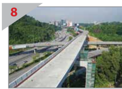
8 PERINGKAT PEMBINAAN SETERUSNYA Persediaan untuk kerja-kerja pemasangan trek sedang dilakukan di atas jambat MRT yang telah siap di sepanjang Lebuhraya SPRINT berhampiran Persimpangan Kiara.
