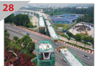
28 LINTASAN KHAS Pandangan dari udara pembinaan rentang khas jambat di atas Lebuhraya Cheras-Kajang bagi landasan cabang menuju ke Depoh Kajang.
