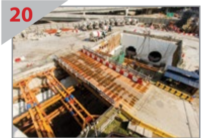
20 PENGHUJUNG BAHAGIAN SELATAN Pandangan dua bukaan terowong di Portal Maluri, dan pembinaan seksyen terowong menggunakan kaedah 'cut-and-cover' sedang dijalankan.
