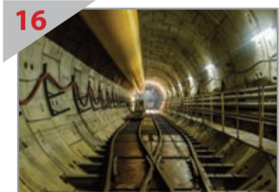
16 PEMBINAAN TEROWONG Landasan-landasan lokomotif kerja di dalam terowong berhampiran Syaf Pelancaran Inai.
