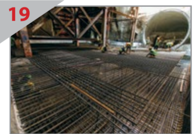
19 KERJA PAPAN DASAR Pembinaan papak dasar bagi Stesen MRT Maluri sedang dijalankan.
