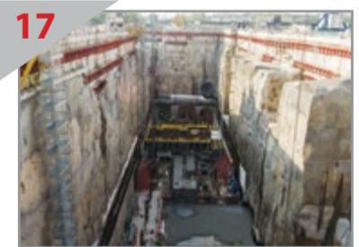
17 AKAN DATANG Aras platform Stesen Tun Razak Exchange sedang dibina.
