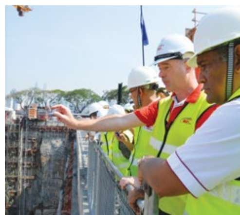
■ TAKLIMAT MENYELURUH - Pengarah Terowong Bawah Tanah, Encik Blaise Mark Pearce menyampaikan taklimat kepada Ketua Pengarah Tanah dan Galian, Dato' Sri Haji Azemi Kasim tentang kerja-kerja pembinaan yang sedang dijalankan di tapak pembinaan Stesen Cochrane.
