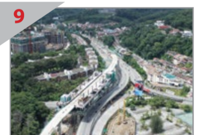
9 TAPAK KERJA YANG MENCABAR Pandangan dari udara pembinaan Stesen Pusat Bandar Damansara di atas Persimpangan Ma'arof di Lebuhraya SPRINT.
