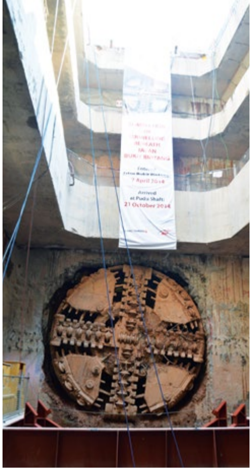
■ SELESAI • Keadaan Mesin Pengorek Terowong Inai 2 selepas penembusannya di Syaf Pelancaran Pudu pada 22 Oktober 2014. Penembusannya menandakan berakhirnya penggalian terowong di bawah Jalan Bukit Bintang yang menerusi bahagian Formasi Batu Kapur Kuala Lumpur yang mencabar.
