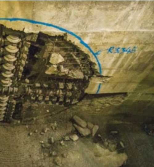
■ 下隧道 • “依耐一号”隧道掘进机于2014年10月17日在富都始发井破土而出。
