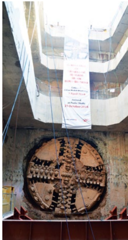
■ 大功告成 • 2014年10月22日，“依耐二号”隧道掘进机在富都始发井破土而出。这次的出土意味着武吉免登路底下的部分，以及高难度的吉隆坡石灰岩结构部分的隧道挖掘工程，宣告完成。
