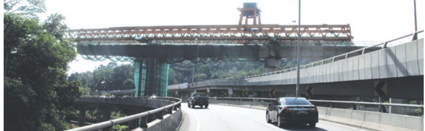
■ 公共安全 • 当局采取各种措施来减低捷运工地的意外风险。
