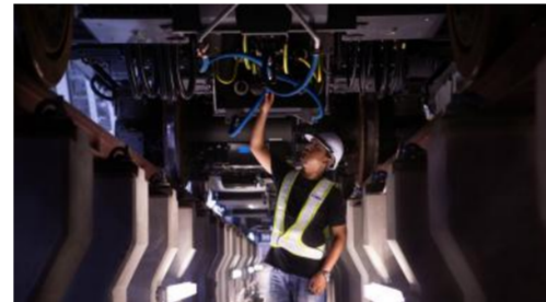
■ 谨慎检查：在双溪毛糯车库内，一名工程师正在检查一辆捷运列车底部的电缆和管道。图片由西门子公司提供。
