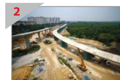
2 MENUJU SASARAN Pandangan rentang jambat MRT yang telah siap bagi landasan cabang dari Depoh Sungai Buloh (kanan) sementara gantri pelancar sedang membina jambat bagi landasan utama.
