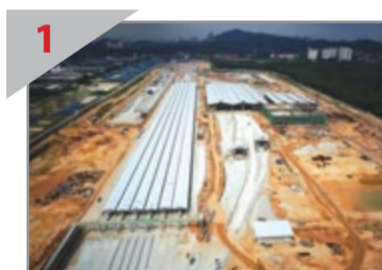
1 SEMAKIN SIAP Pandangan dari atas Depoh Sungai Buloh di mana terletak kawasan menyimpan tren berbumbung (kiri), bangunan penyelenggaraan stok kereta api (tengah), bangunan infrastruktur (kanan, belakang) dan bangunan pentadbiran yang juga berfungsi sebagai pusat kawalan operasi (kanan, depan).
