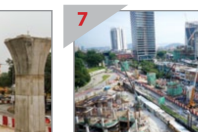
7 TAPAK KERJA YANG SIBUK Pembinaan Stesen TTDI berhampiran Plaza TTDI sedang dijalankan.
