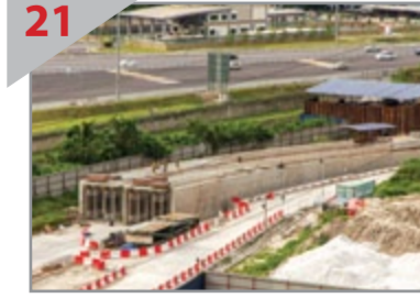
21 ATAS TANAH Pandangan seksyen yang menggunakan kaedah 'cut and cover' di portal Maluri di mana tren MRT akan muncul naik dari bawah tanah.
