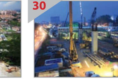
24 JAM SEHARI Pandangan kerja pembinaan Stesen MRT Kajang sedang dijalankan pada waktu malam.
