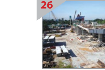
26 GIAT DIBANGUNKAN Pembinaan Stesen Taman Koperasi Cuepacs bersebelahan Lebuhraya Cheras-Kajang sedang dijalankan.
