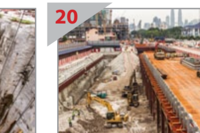
20 KERJA PENGALIAN Kekokat Stesen MRT Maluri sedang digali sementara pelantar digunakan untuk menutup kawasan korekan bagi memberi lebih ruang kerja dan lencangan trafik.
