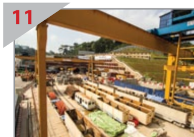
11 PENGHujung TEROWONG Pandangan gerabak mengangkut keluar bahan dari mesin pengorek terowong di Portal Semantan.
