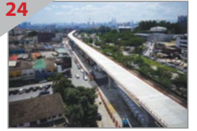
24 KE ARAH BANDAR RAYA Pandangan jambat yang telah siap dibina di sepanjang Jalan Cheras di Taman Midah.
