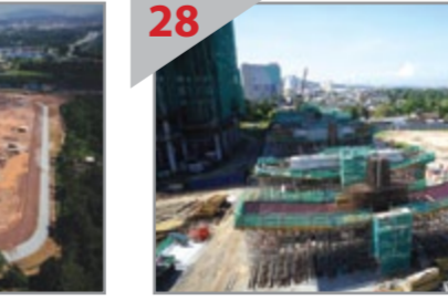
28 STESEN AKAN DATANG Pandangan pembinaan Stesen Sungai Kanton sedang dijalankan.
