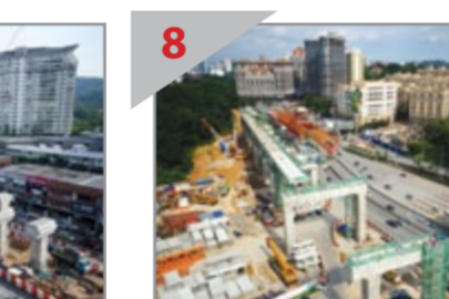
8 GIAT DIBANGUNKAN Pembinaan Stesen Phileo Damansara giat berjalan.
