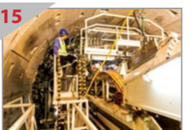
15 BEKERJA KERAS Pembinaan Stesen Taman Suntext bersebelahan Lebuhraya Cheras-Kajang sedang dijalankan.
