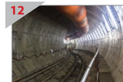
12 PENGALIAN TEROWONG Pandangan terowong yang telah selesai dan pandangan belakang mesin pengorek terowong yang terus menggali terowong ke arah Stesen MRT Pasar Seni.
