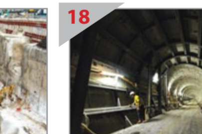
18 PANDANGAN TEROWONG Pandangan terowong dari Cochrane menuju ke Pasar Rakyat.
