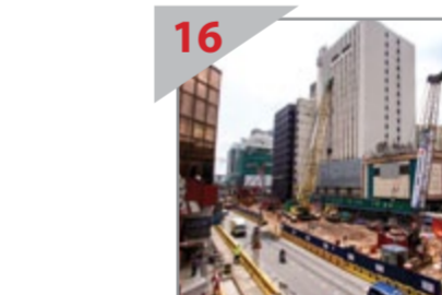
16 RUANG KERJA TERHAD Pandangan tapak kerja Stesen MRT Bukit Bintang di hadapan BB Plaza.
