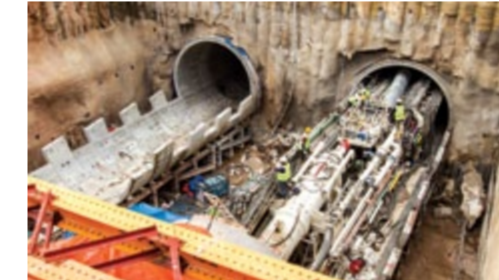
■ KERJA SELESAI • Pandangan terowong bawah tanah yang telah siap digali di portal, dengan TBM Maluri 2 sedang dibuka (kanan).
