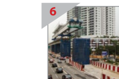
6 MESIN MENAKJUBKAN Gantri pelancar mendirikan jambat MRT di sepanjang Jalan Damansara.
