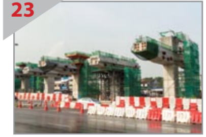
23 SOKONGAN KUAT Tiang-tiang sokongan dan rasuk silang (cross beams) bagi stesen MRT sudah mulai terbentuk di hadapan deretan kedai di Taman Midah, Cheras.
