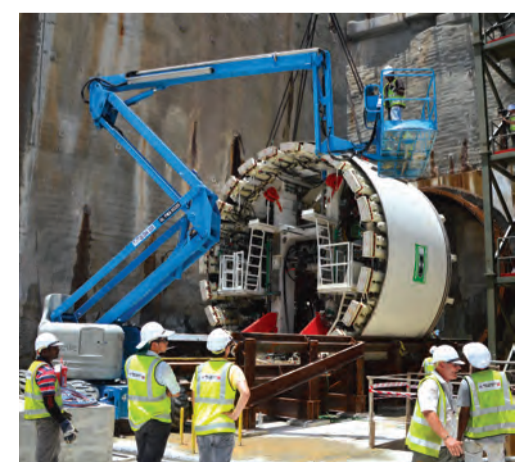
KEDUDUKAN TEPAT • Perisai tengah mesin pengorek terowong selamat diturunkan ke dasar Syaf Pelancaran Cochrane.
