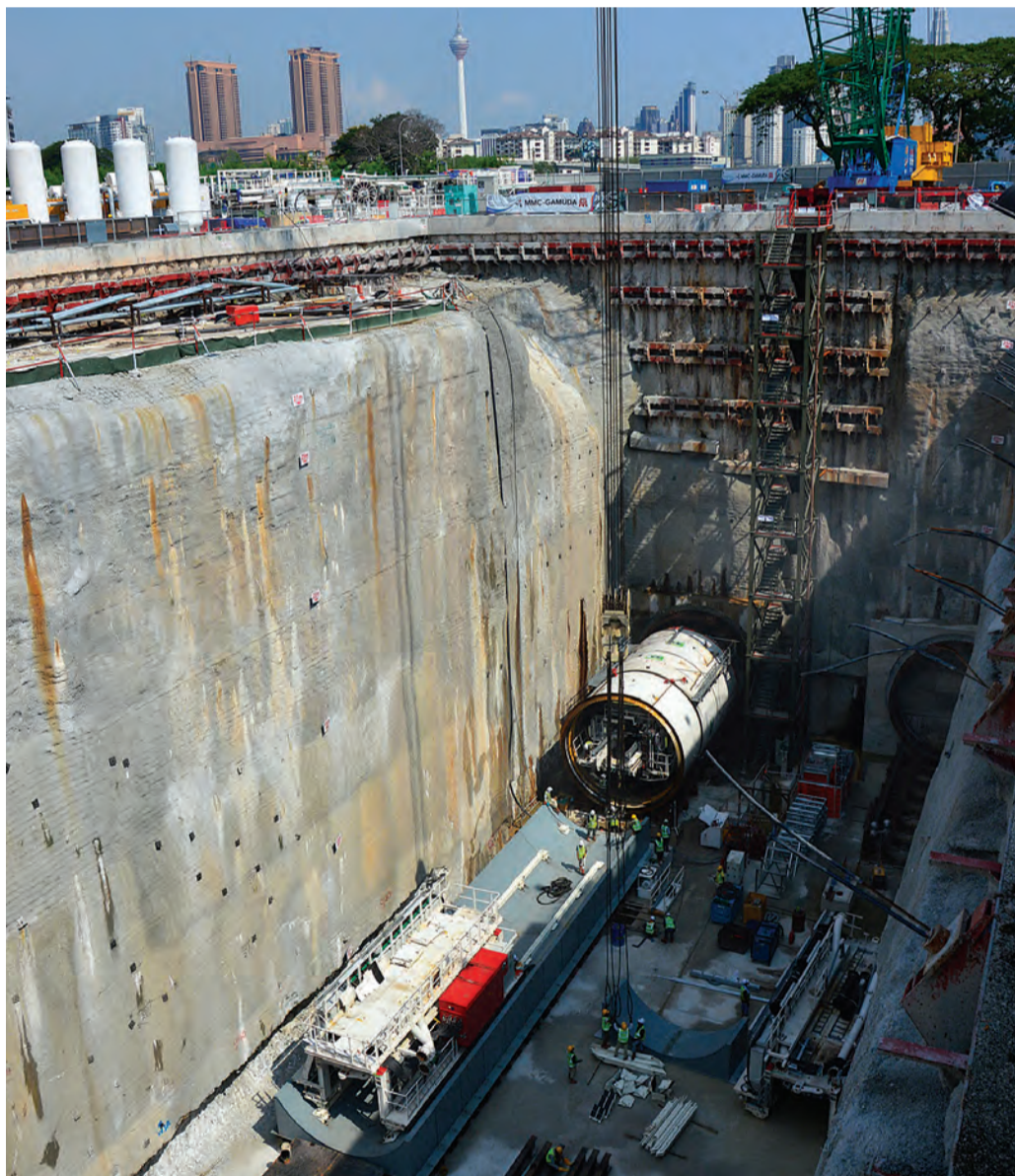
SEMAKIN JELAS • Mesin Pengorek Terowong Variable Density pertama dunia sedang dipasang di dalam Syaf Pelancaran Cochrane.
