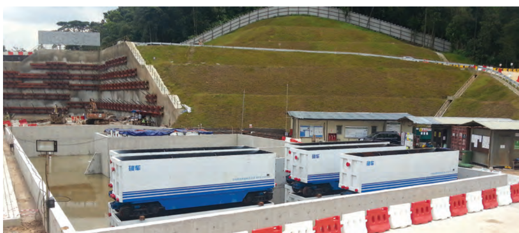
BAHARU • Kendaraan yang akan membawa sisa tanah dari mesin pengorek terowong keluar untuk dibuang.
