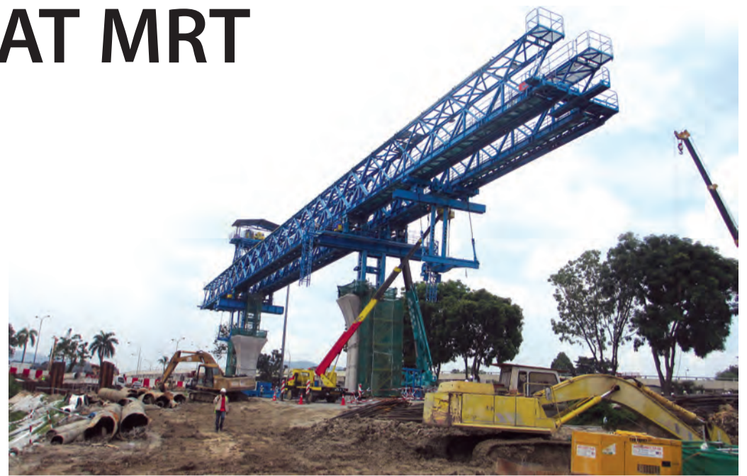
RUMIT • "Launching gantry" pertama Projek MRT sedang dipasang di lokasi Stesen Bandar Tun Hussein Onn.
