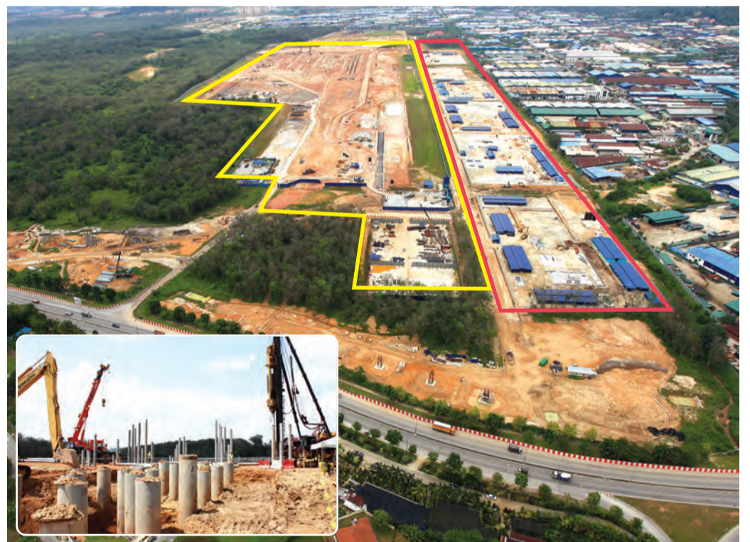
LUAS • Pandangan dari udara tapak pembinaan Depoh Sungai Buloh (dalam kawasan kuning), bersama Kuarters Pekerja Sungai Buloh bersebelahannya (dalam kawasan merah). Gambar kecil menunjukkan kerja memantakkan cerucuk di tapak.
