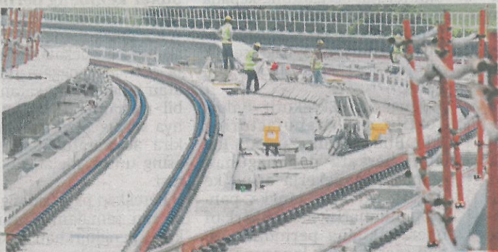
Pekerja melakukan kerja pembinaan Stesen MRT Seksyen 16.
