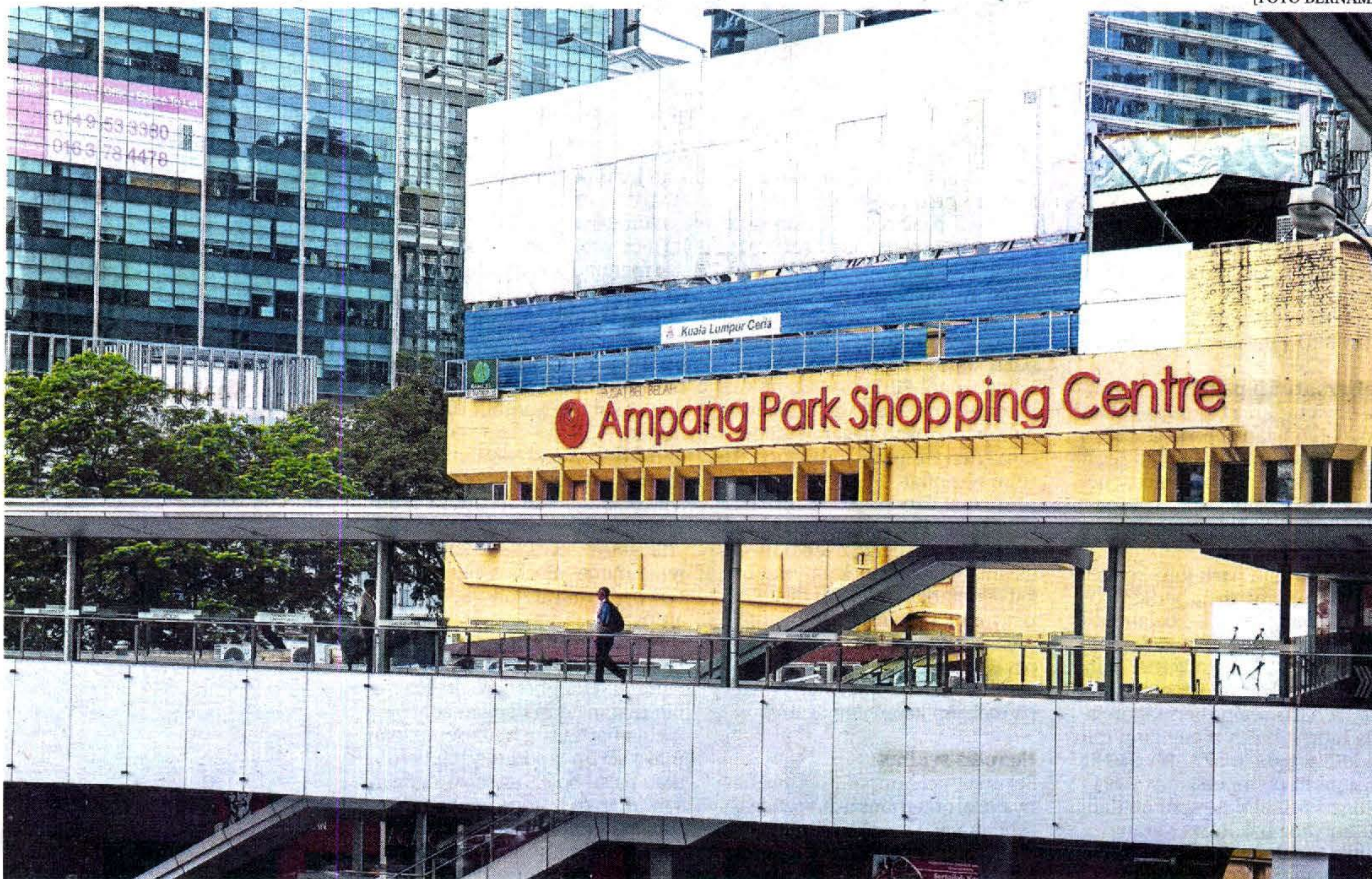
Kompleks beli-belah Ampang Park akan dirobohkan tidak lama lagi dan peniaga terbabit sudah diberi notis supaya mengosongkan bangunan untuk memberi laluan kepada pembinaan landasan ke-2 MRT dan terowong yang menyambungkan stesen S16 MRT dengan stesen LRT Ampang Park yang dibina di bawah kawasan bangunan berkenaan.
