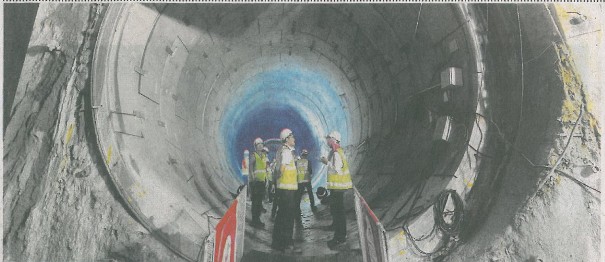
PEMBINAAN terowong dalam projek MRT mampu menjimatkan ruang dan mengurangkan kesesakan jalan raya di ibu negara. - UTUSAN/MOHD. NAJIB MOHD. NOR
