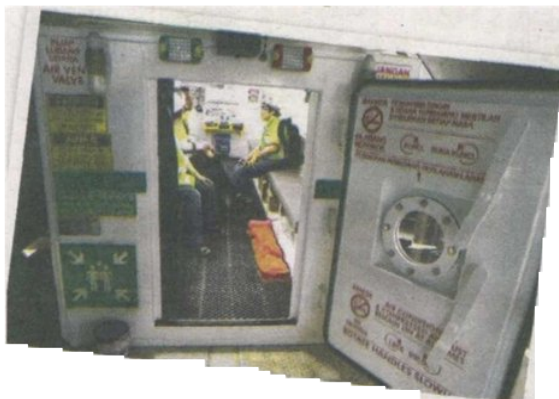
RUANG kebuk perlindungan di dalam terowong hanya mampu memuatkan 20 orang kakitangan pembinaan pada waktu kecemasan.
