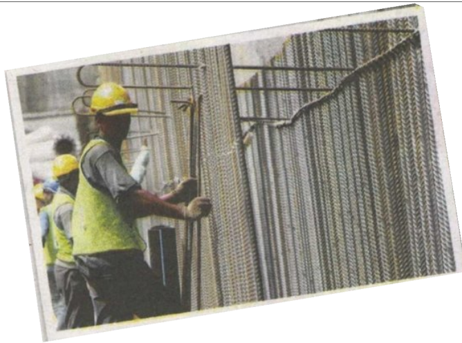
PEKERJA terowong memasang tetulang besi di tapak pembinaan terowong bagi mengukuhkan struktur dinding stesen bawah tanah di Stesen Cochrane.
