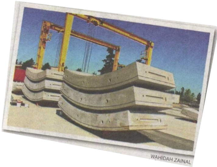
BEGINILAH bentuk segmen yang digunakan untuk membina dinding terowong MRT.
