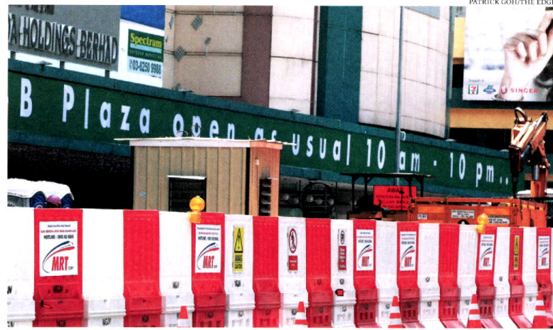
MRT site in Bukit Bintang
