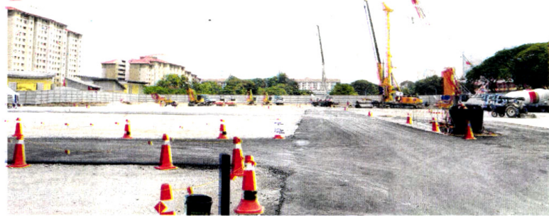
KERJA pembinaan sebuah stesen MRT yang dijalankan di Cochrane, Cheras, Kuala Lumpur.
