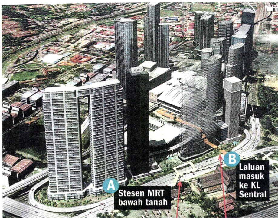
PEMBANGUNAN...kerja pembinaan MRT di KL Sentral giat dilaksanakan.
