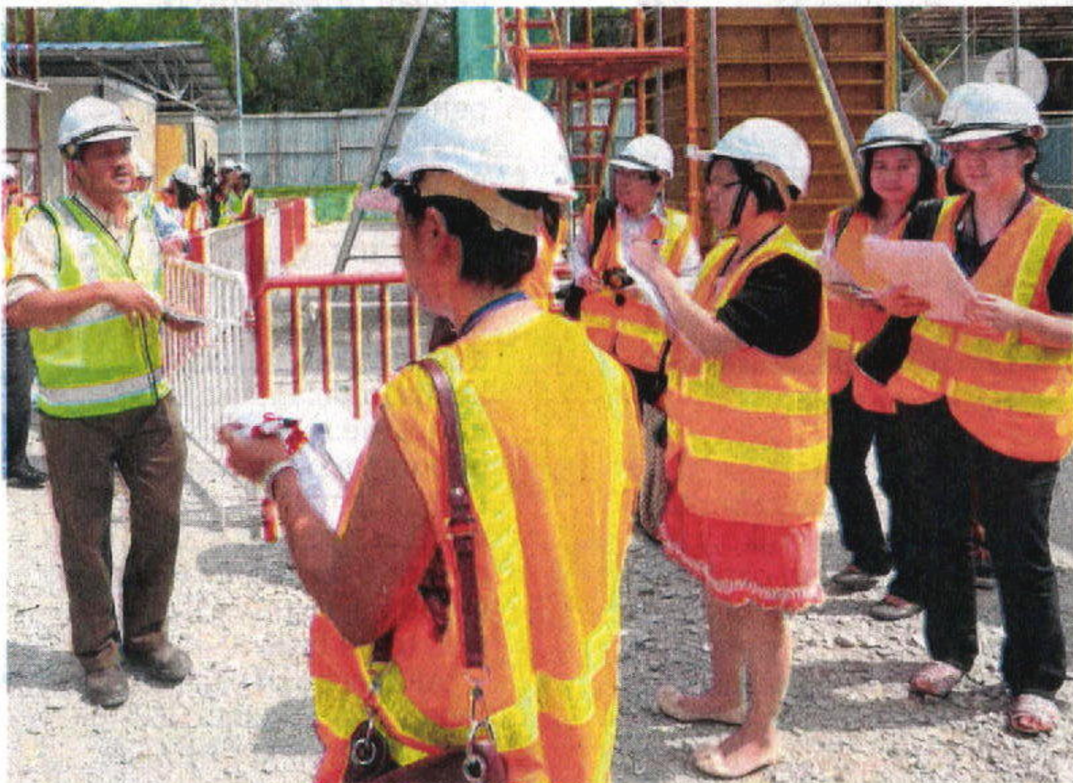
WARTAWAN diberi penerangan mengenai sistem keselamatan dan peralatan digunakan untuk pembinaan MRT di Sungai Buloh, semalam.
